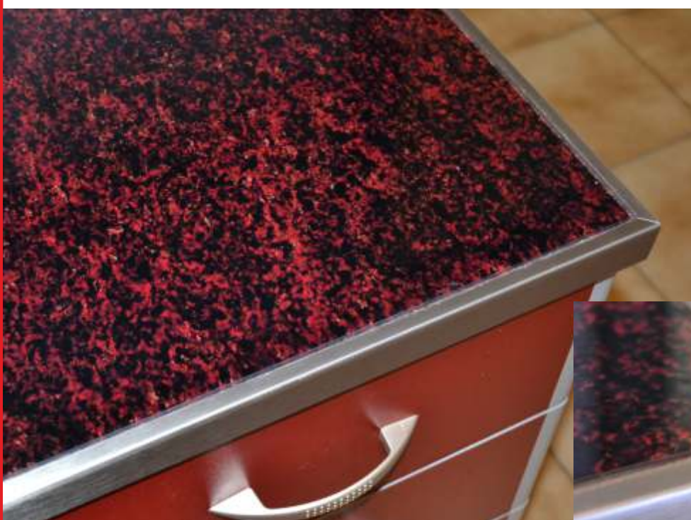
detail osadenia sklenenej pracovnej dosky a antikorovej lišty
